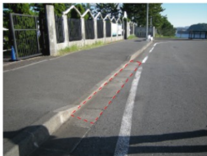
段差1 ベニア補正 パンチカーペット 500巾×6m
